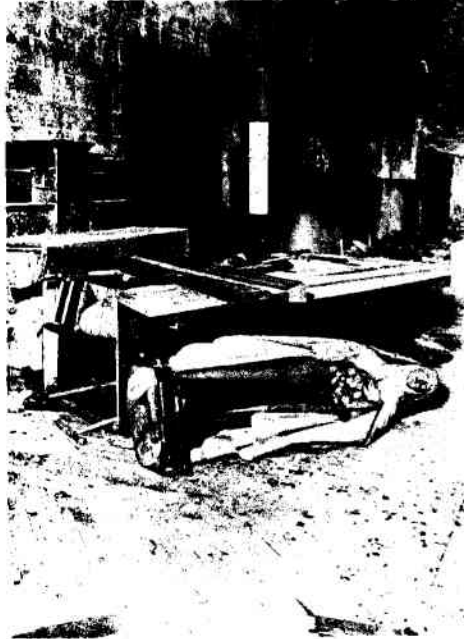
Estado de un convento, después de su incendio, en el que se ven las imágenes rodando por el suelo.
